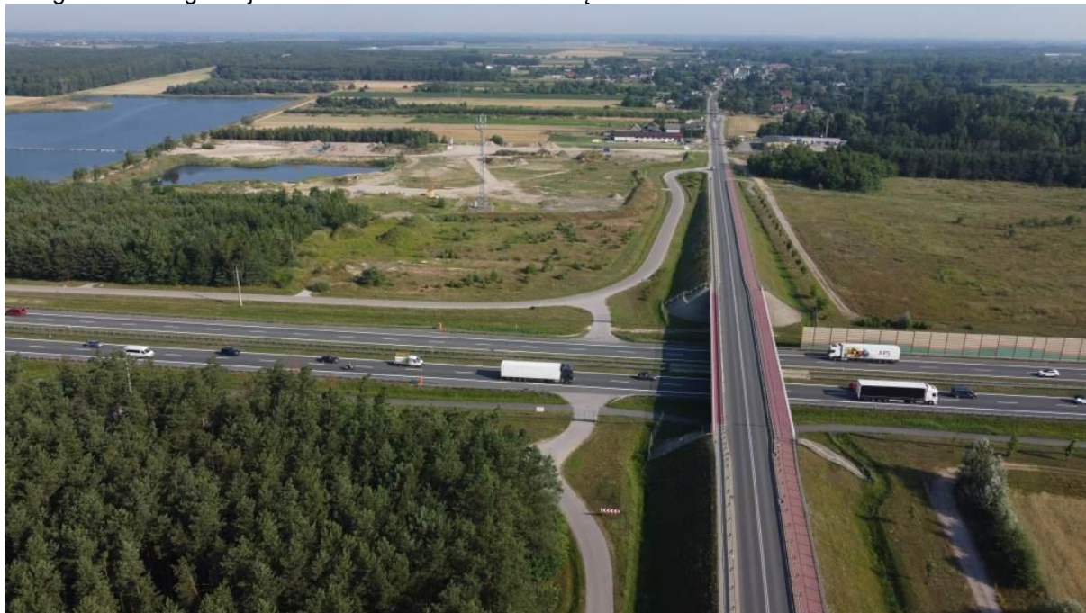
Fotografia 5. Droga wojewódzka nr 705 nad autostradą A2.
