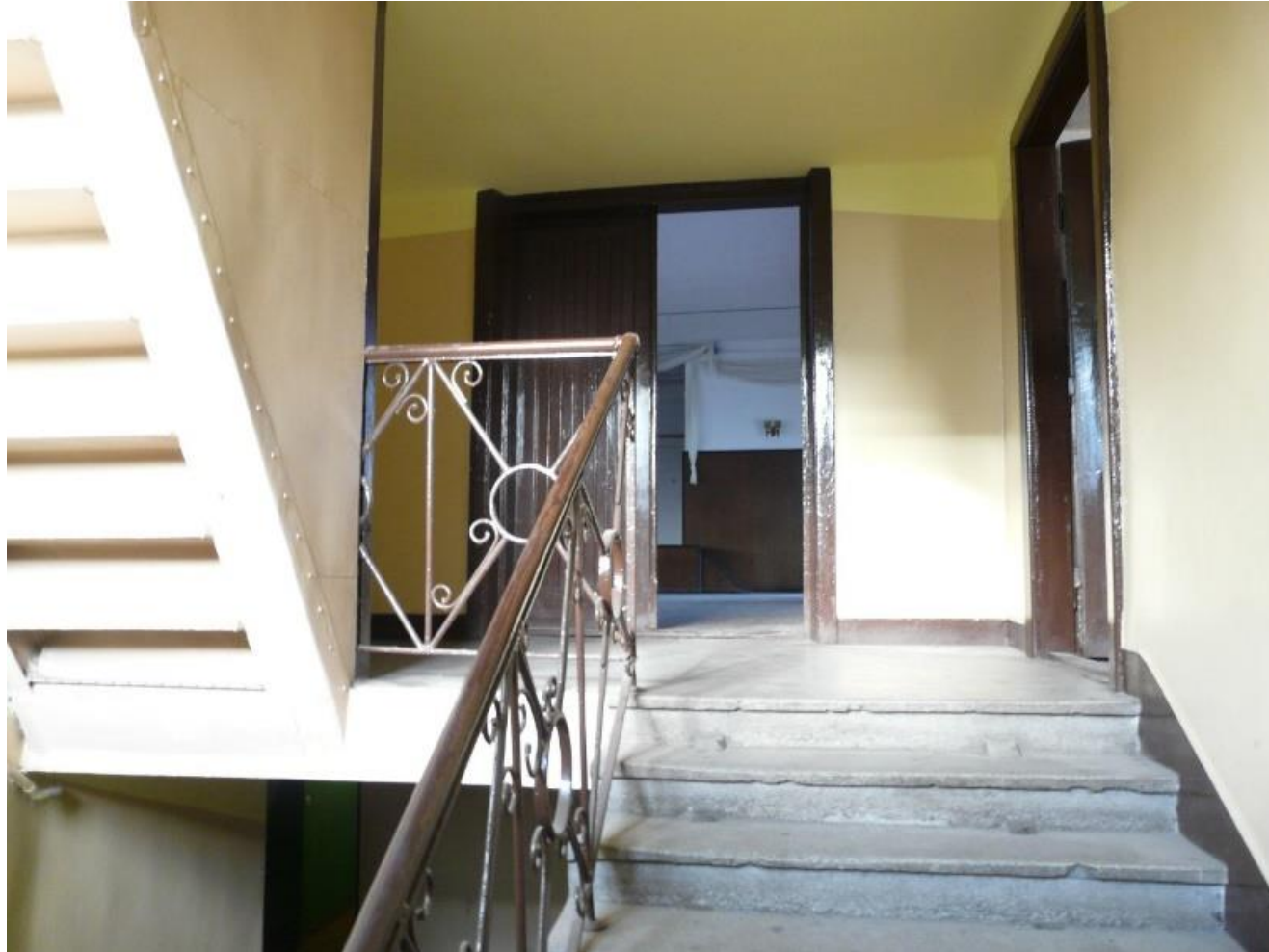
Rysunek 17. Klatka schodowa na piętro przed remontem
