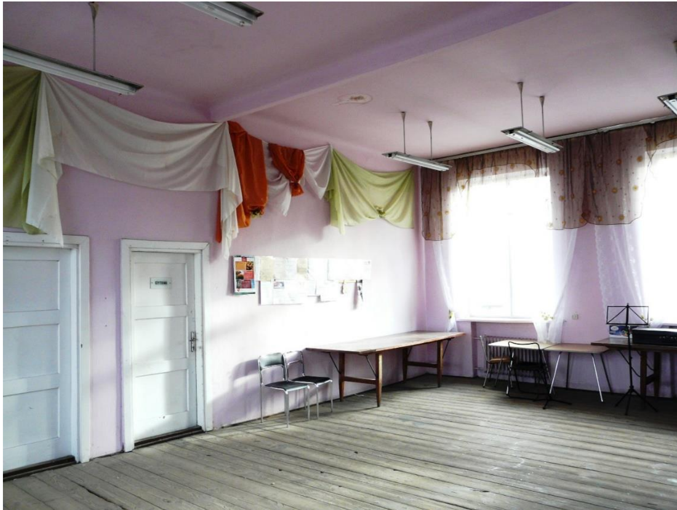
Rysunek 7 pomieszczenie na piętrze przed remontem
