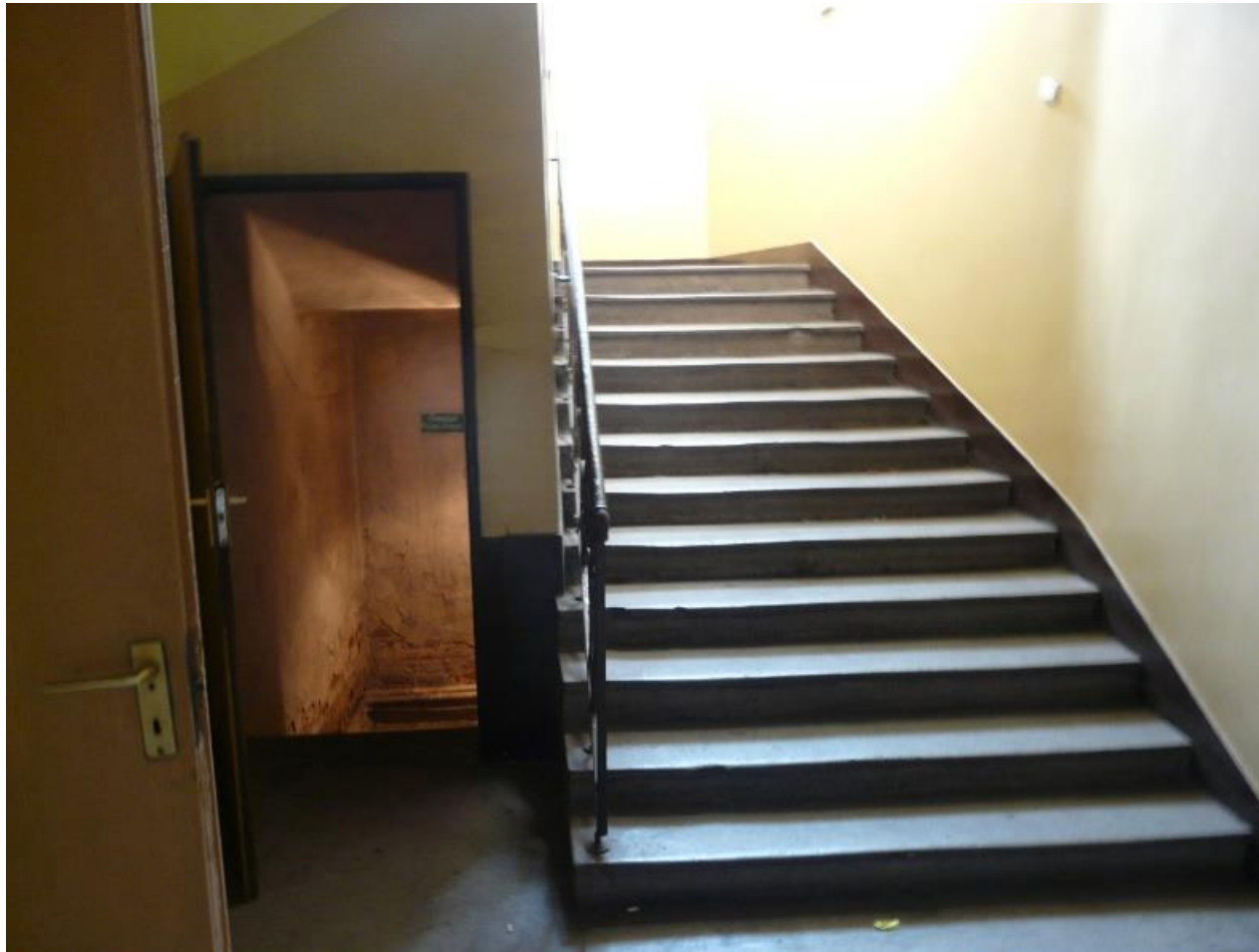
Rysunek 16. Klatka schodowa na piętro przed remontem
