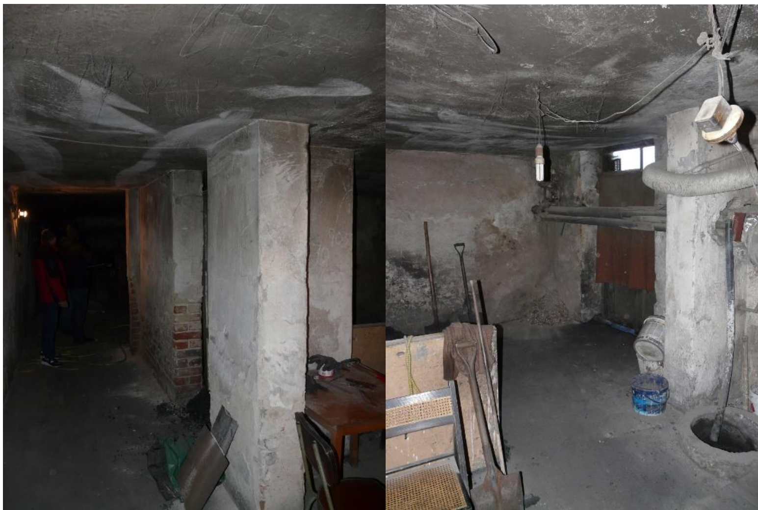
Rysunek 19. Piwnice i skład opału przed remontem
